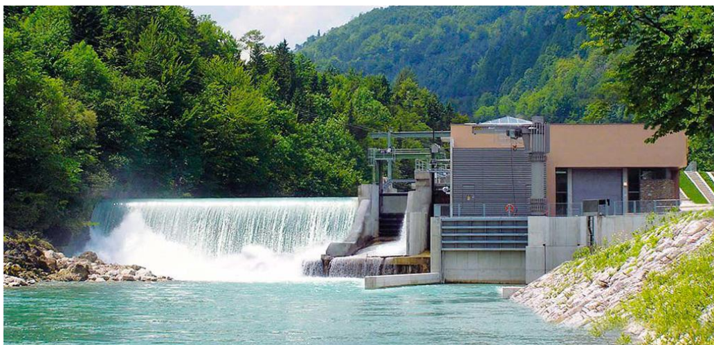
Slika 2.9. Fotografija male hidroelektrane
