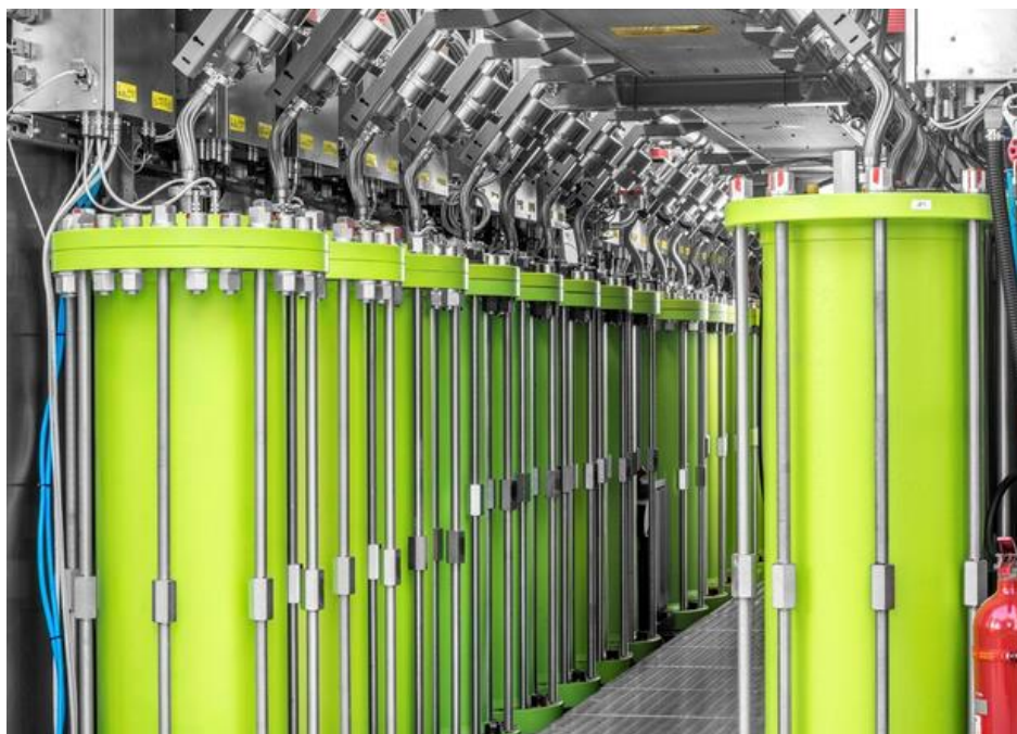
Slika 2.14 Fotografija sustava za pohranu energije zamašnjakom
