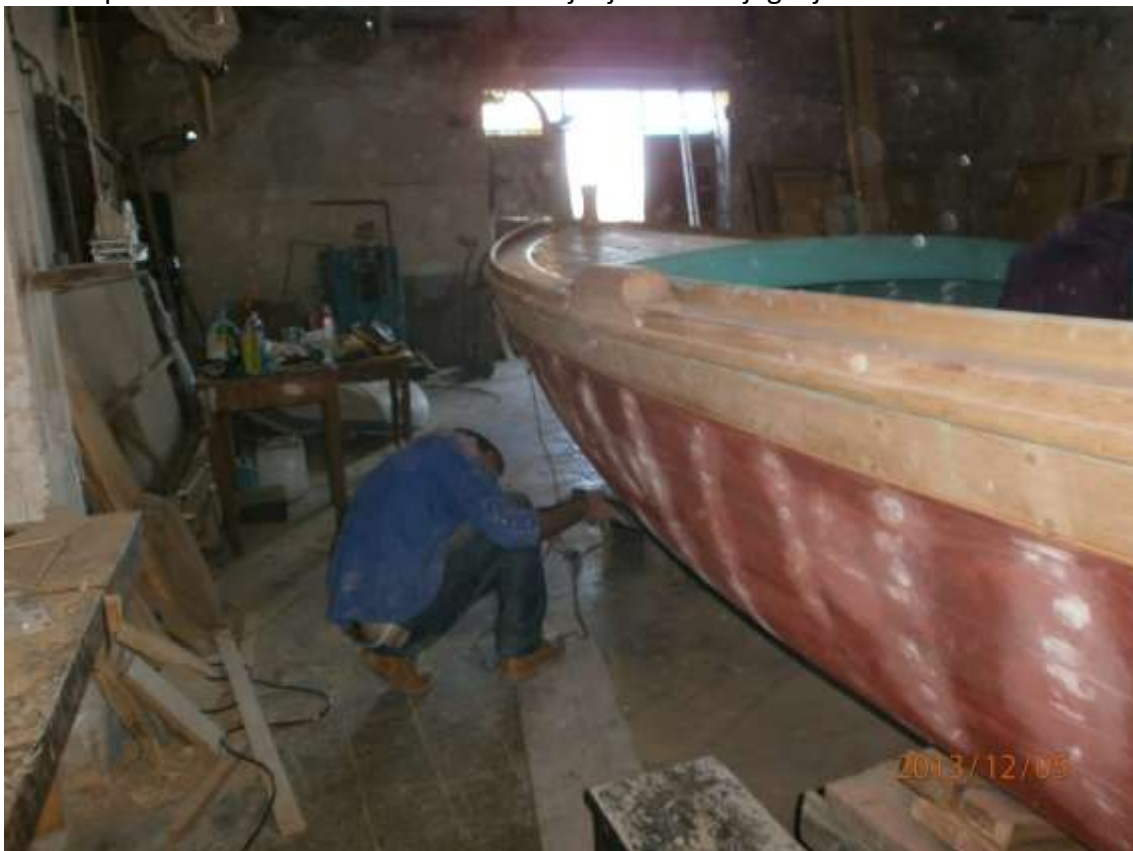
Sl. 20 Nakon postavljanja palube i oplata Josip se uhvatio zaštićivanja podvodnog dijela
