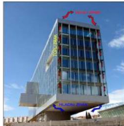
Višekatna dvostruka koridor fasada Sveučilišne knjižnice u Splitu
