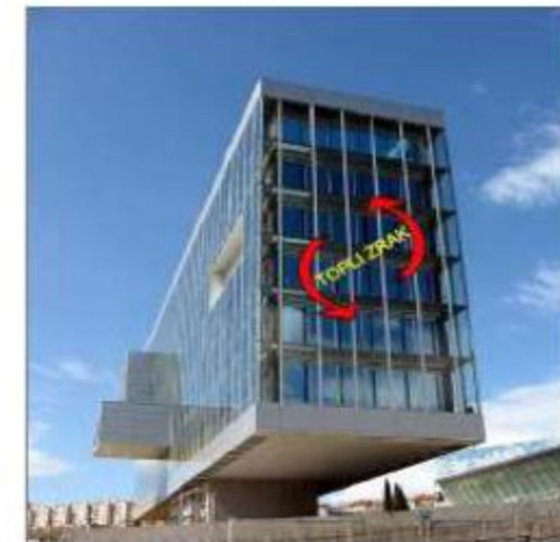
Višekatna dvostruka koridor fasada Sveučilišne knjižnice u Splitu
